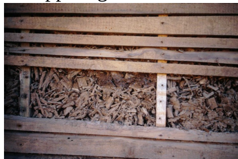
Holz hackschnitzel in Lehmschlämme
